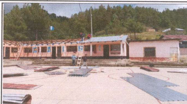
Foto 2: Pegando lamina para el nuevo techo
