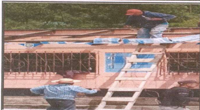
Foto1: Cambio de techo
